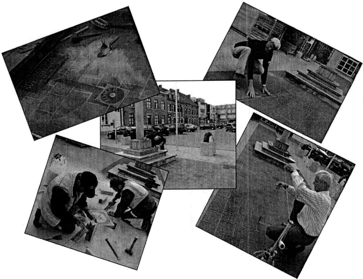
Foto 2: enkele sfeerbeelden van de aanleg van de middaglijn en het meten van de helling van het marktplein. Het bepalen van deze helling langs de te bouwen middaglijn gebeurt hier nog op een 'primitieve' manier. Een dikke proficiat aan de gemeentearbeiders die voor de uitvoering zorgden.
